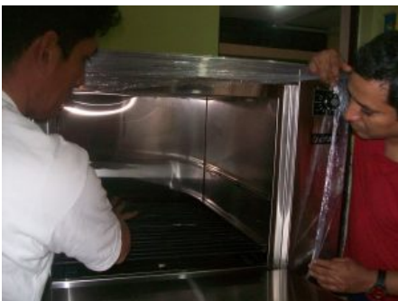
Installation et dernier contrôle
